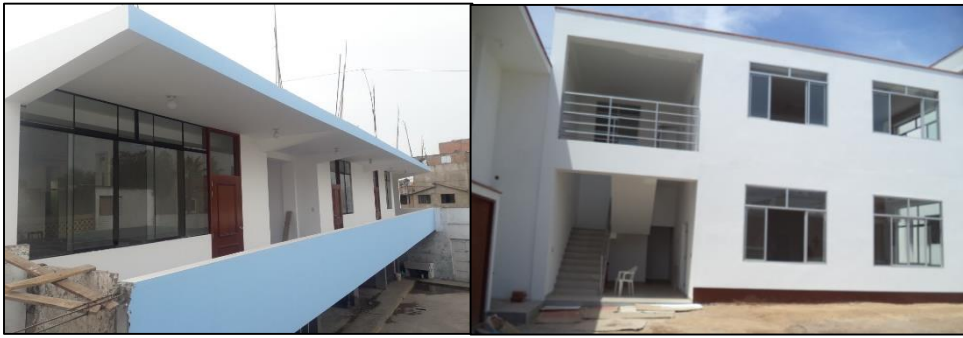
Construcción de CETPROs
